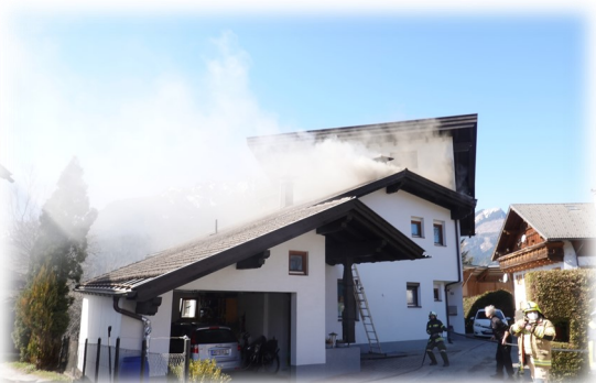
23.03.2022 - Brand Dach, Pflach
